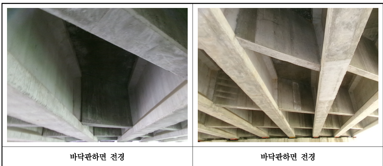
【사진 2.3.2】 바닥판하면 전경
