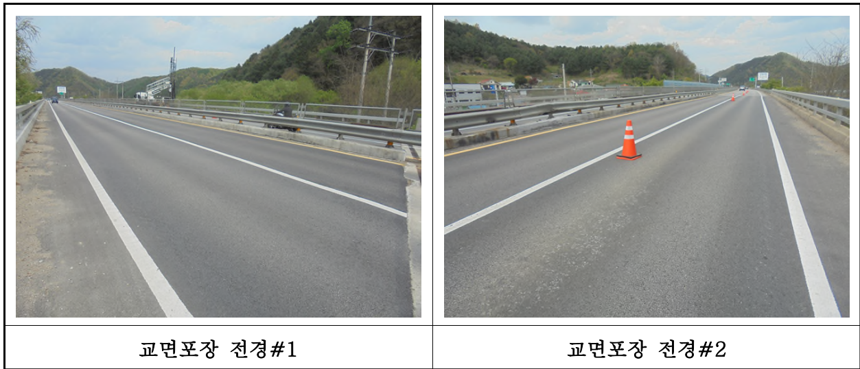
【사진 2.3.19】 교면포장 전경
