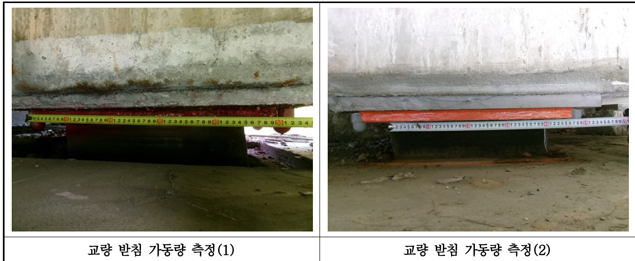
【사진 2.3.15】교량받침 이동량 측정
