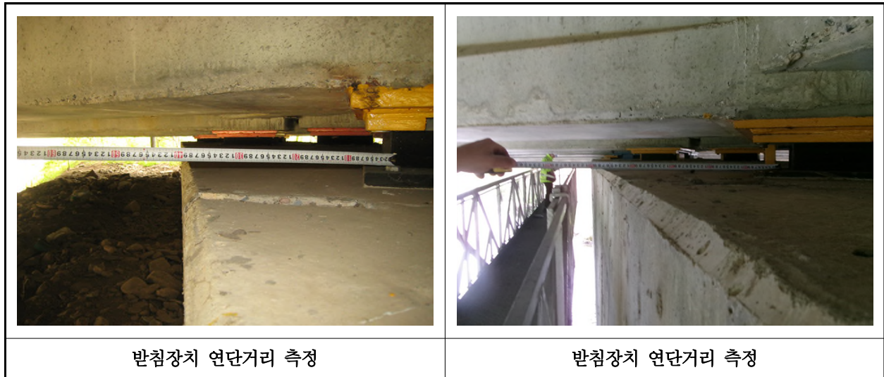
【사진 2.3.14】 교량받침장치 연단거리측정
