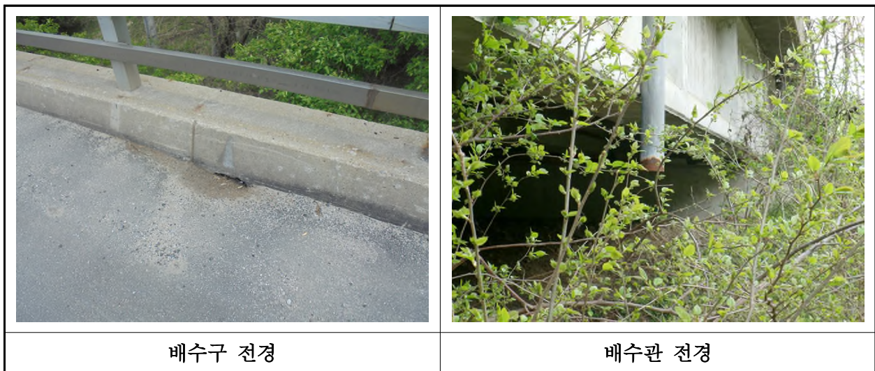
【사진 2.3.21】 배수시설 전경
