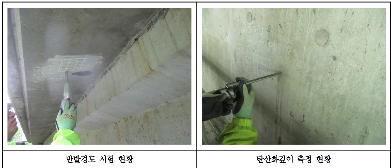
【사진 2.4.1】 콘크리트 내구성조사 현황
