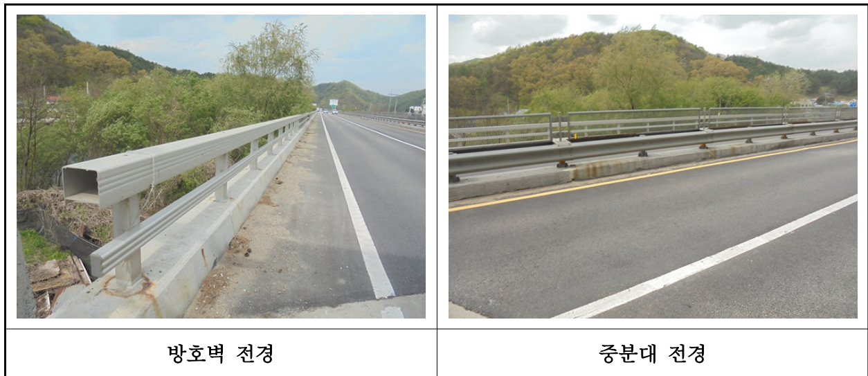
【사진 2.3.23】 방호벽 및 중앙분리대 전경
